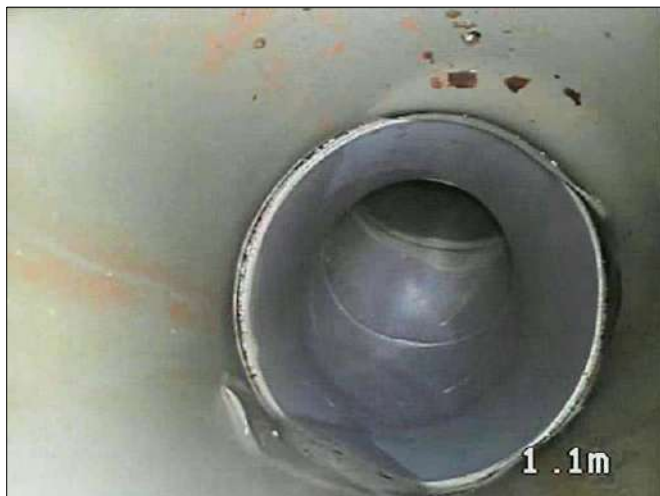
Ima. 8 1,1 m Tubería en buen estado
