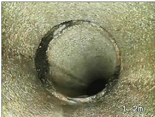
Ima. 5 1,4 m Junta abierta, con filtración de agua
