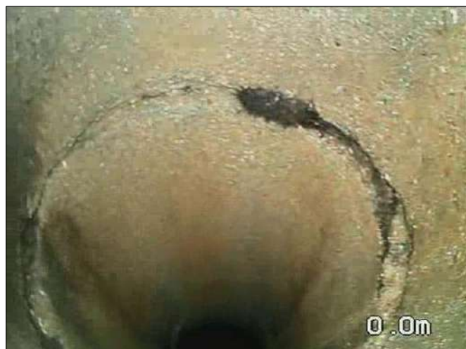
Ima. 1 0,5 m Junta abierta, con filtración de agua
