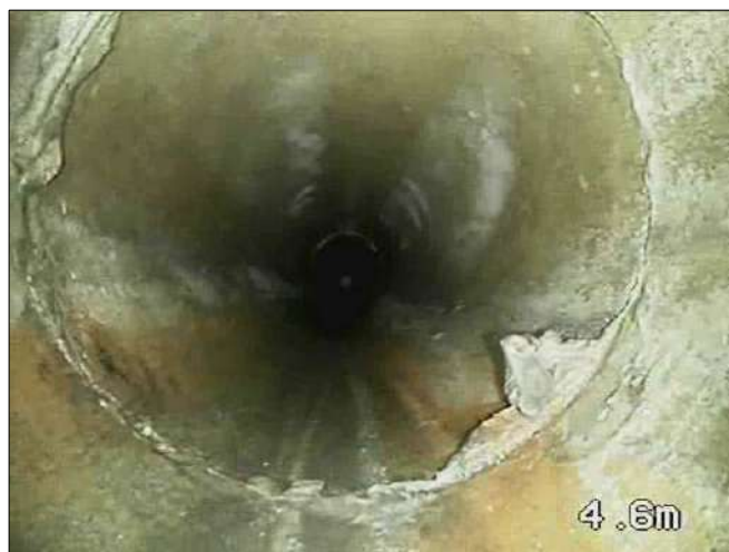
Ima. 2 4,6 m Tubería en buen estado
