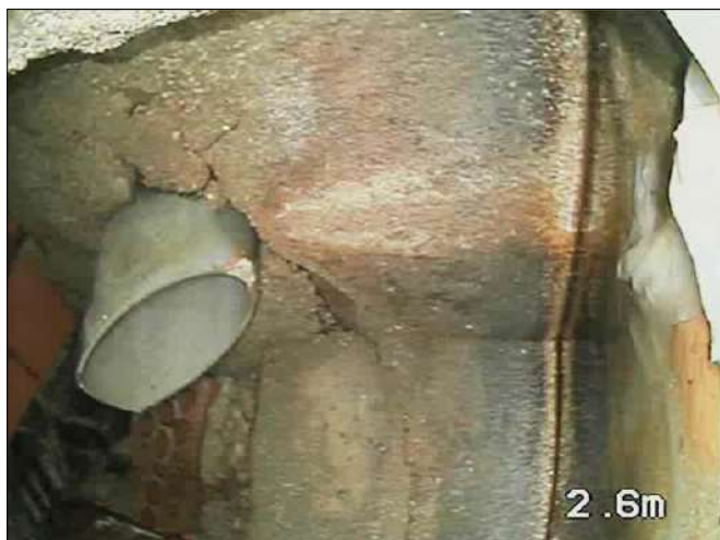
Ima. 7 2,7 m Arqueta en malas condiciones
