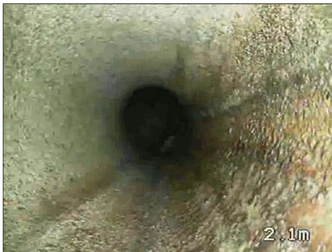
Ima. 6 2,1 m Desgaste mecánico, con filtración de agua
